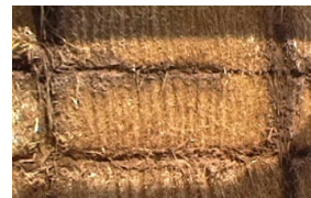
Joints remplis avec un mélange terre paille pour un enduit terre
