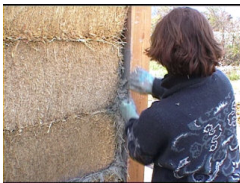
Remplissage des fissures avec un béton de chaux et de paille
