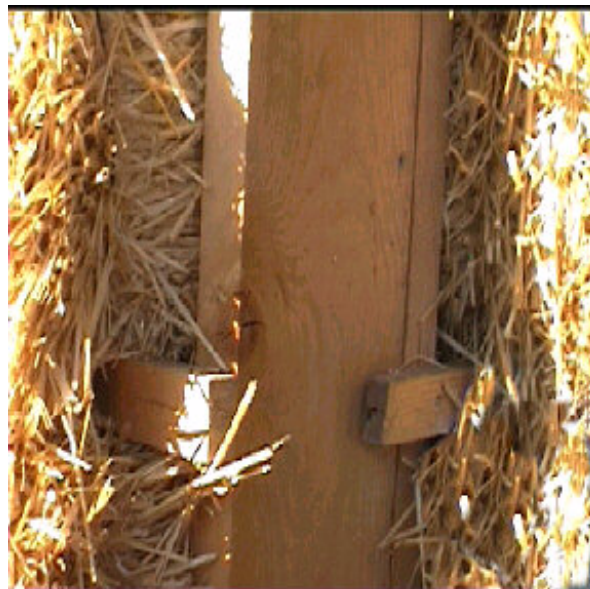
Angle avant pose de la fibralth et de la fibre polyamide
